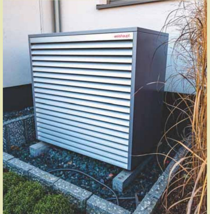
So kompakt ist eine moderne Luft-Wärmepumpe. Hier ein Beispiel aus Hannover-Laatzten.
