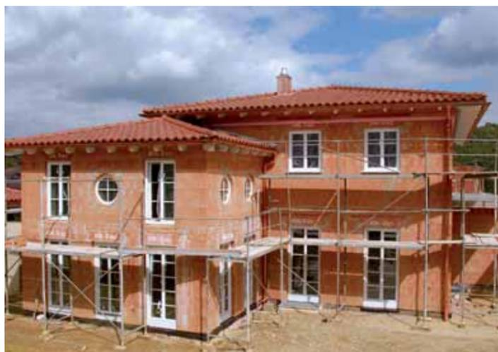
Schallschutzkonzept mit Ziegeln: Die massive Wand sowie Ergänzungsprodukte wie Ziegel-Rollladenkästen schützen die Bewohner dieses Hauses optimal vor Außenlärm.
