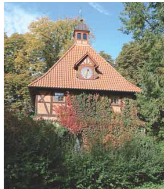
„Der Schnegaer Zwinger“ stammt laut verschiedener Quellen aus dem Jahr 1317 und diente in früheren Zeiten der Verteidigung und dem Zugang des Gutshauses. Auch von einer Nutzung als Gefängnis wird berichtet.
