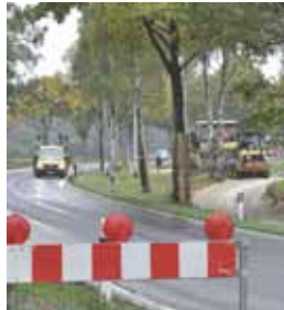
Die Arbeiten am Fahrradweg entlang der B 71 sorgten in den vergangenen Wochen zeitweilig für Verkehrsbehinderungen. Foto: dre
